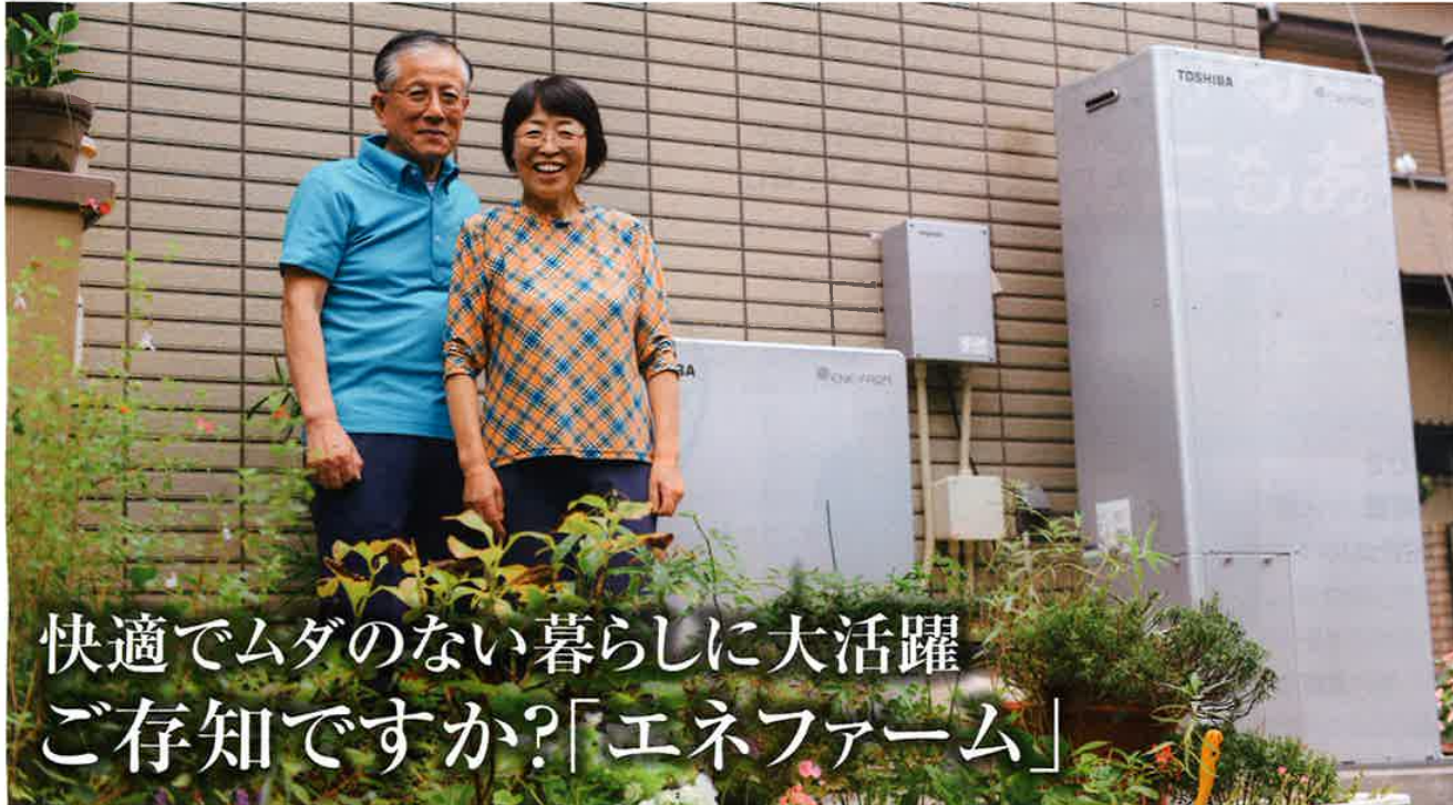
家の北側に設置したエネファーム。背の低い方が発電ユニット、高い方が貯湯ユニット。コンパクトなセパレートデザイン。
