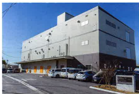
狭山市に2014年に建てられたばかりの製造工場。
