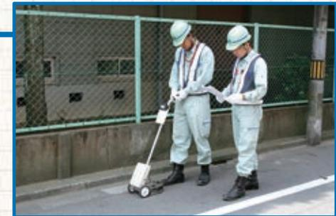
道路に埋まっているガス導管の維持管理のため、定期点検、ガス漏れ検査、主要導管パトロール等を実施しています。導管の周囲で他企業が工事を行う際は事前に打合せを行い、導管損傷防止のための適切な保安措置を講じます。
