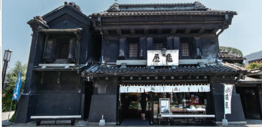
堂々とした黒漆喰(しっくい)の蔵造りが風格をかもし龜屋本店。建設は明治27(1894)年。
