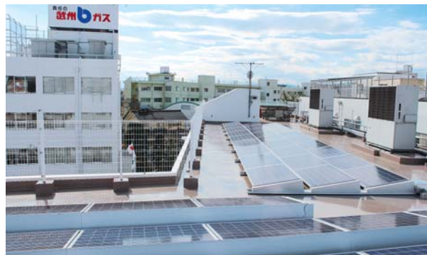
川越本社屋上 太陽光パネル
