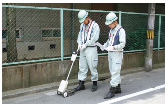
導管漏えい検査
