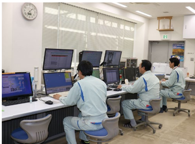
オペレーター室
