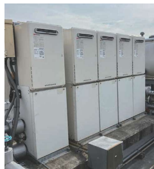
連結給湯システム(マルチ給湯器)
