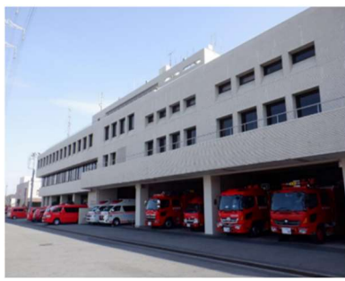
【柏市消防局庁舎】
